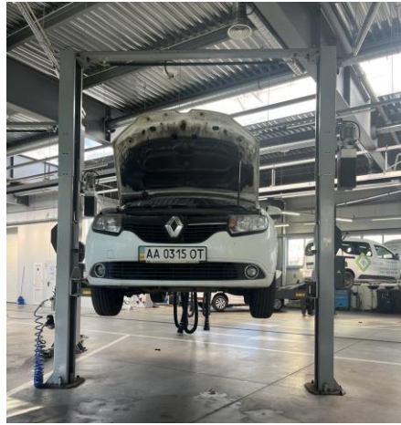
Рис. 3.1. Двостійковий гідравлічний автомобільний підіймач SPLA40
