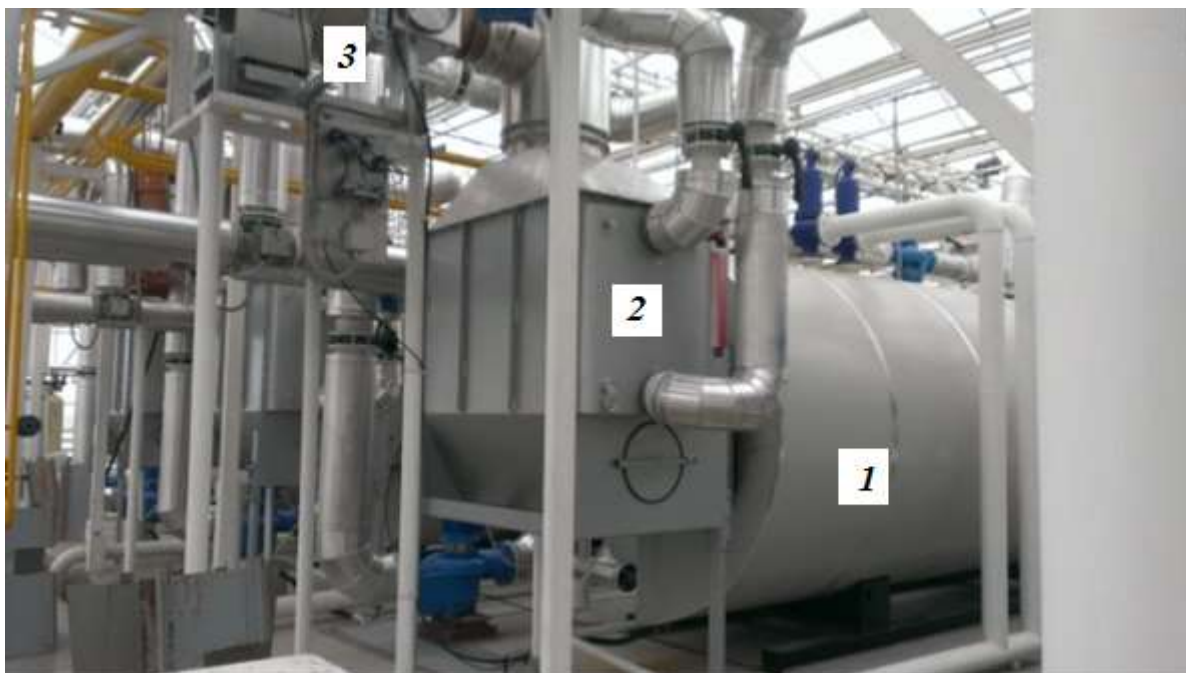
Рис. 1.12. Зовнішній вигляд системи отримання CO 2 для підживлення рослин: 1 – задня частина корпусу котла Viessmann Vitomax 200 WS; 2 – економайзер димових газів у захисному корпусі; 3 – регульовальна заслінка у трубопроводі подачі CO 2 у блок теплиць
