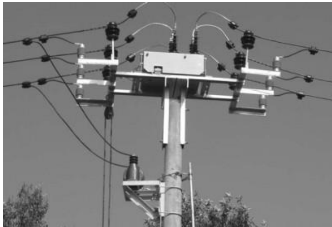
Рисунок 9.10 – Встановлення реклоузера РВА/TEL на опорі лінії електропередавання
