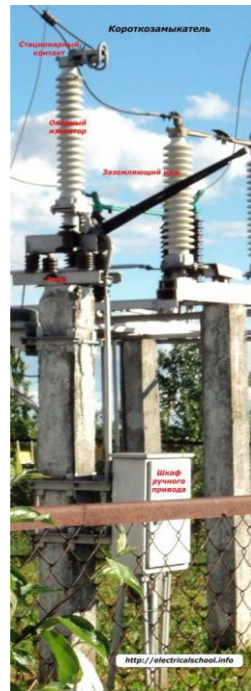
Рисунок 9.4 - Короткозамыкач КЗ-35
