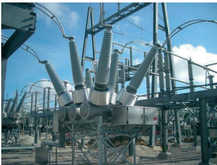
Рисунок 9.13 – Елегазовий вимикач
