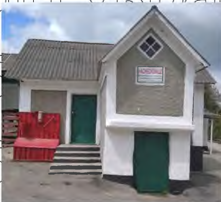
Рис. 4.5. Будівля насіннесховища Вишнівчицького лісництва
