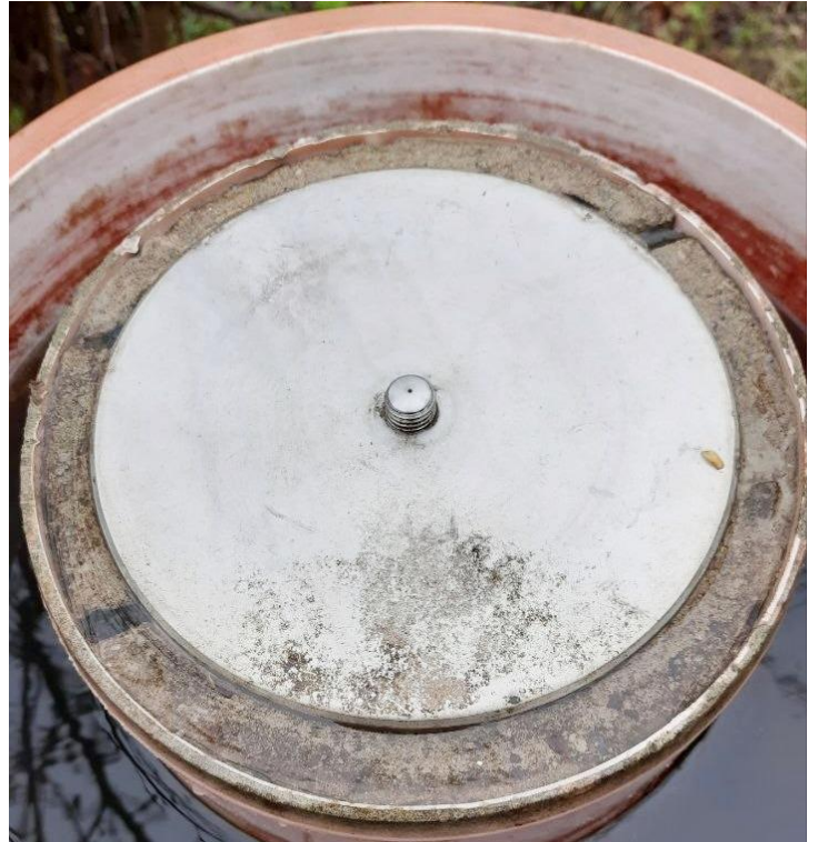
Рис. 2.2 Загальний вигляд вцілілого пункту тунельної триангуляції
