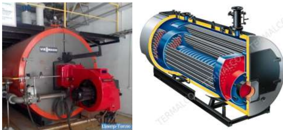
Рис. 1.7. Водогрійний котел Viessmann типу Vitomax 200
