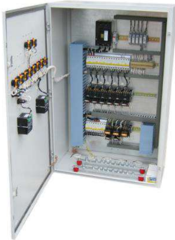
Рис.4.4 Щит автоматизації ЦМУ-1-1
