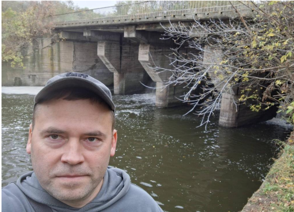
Рис. 1.3.3. Гідротехнічна споруда Скибинецького водосховища
