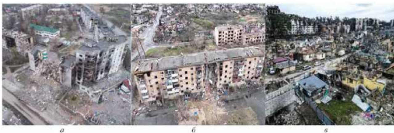
Рис. 1.2 – Приклади фотофіксації зруйнованих і пошкоджених об’єктів Київської області: Бородянки (а); Горенки (б); Ірпеня (в)
