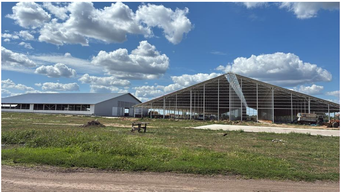
Рис. 3.2.2. Етап будівництва корівника на 1500 корів в умовах ФГ Филенківське (серпень 2025 року)
