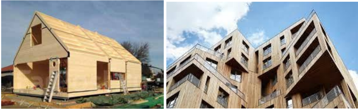
Рисунок 2 – Будівлі з CLT-панелей
