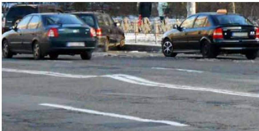
Рис.1.2. Дорожнє покриття на вул. Милославська м. Києва
