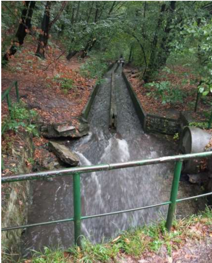
Рис. 3.5. Сучасний вигляд бетонних лотків-швидкотоків призначених для концентрованого водовідведення та їх робота по відведенню води опадів
