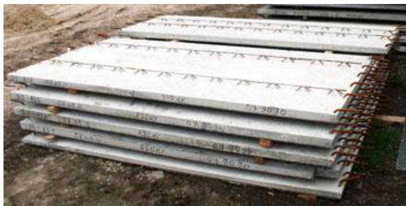
Рис. 1.5. Загальний вид збірно-монолітних конструкції із застосуванням касетної опалубки
