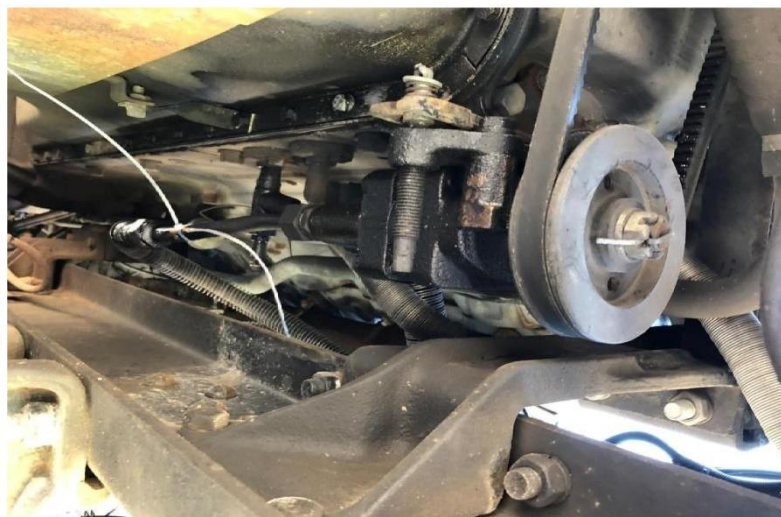
Рисунок 3.6 – Місце приєднання термопар до трубопроводу масляного насоса
