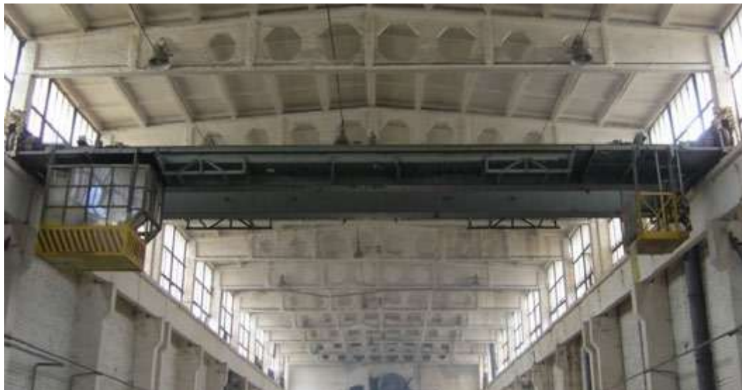
Рис. 1.4. Збірні залізобетонні підкранові балки одноповрхової промислової будівлі прогоном 18,0 м
