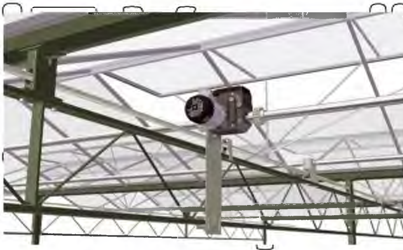
Рис. 3.13. Загальний вид мотор-редуктора в системі вентиляції в теплиці
