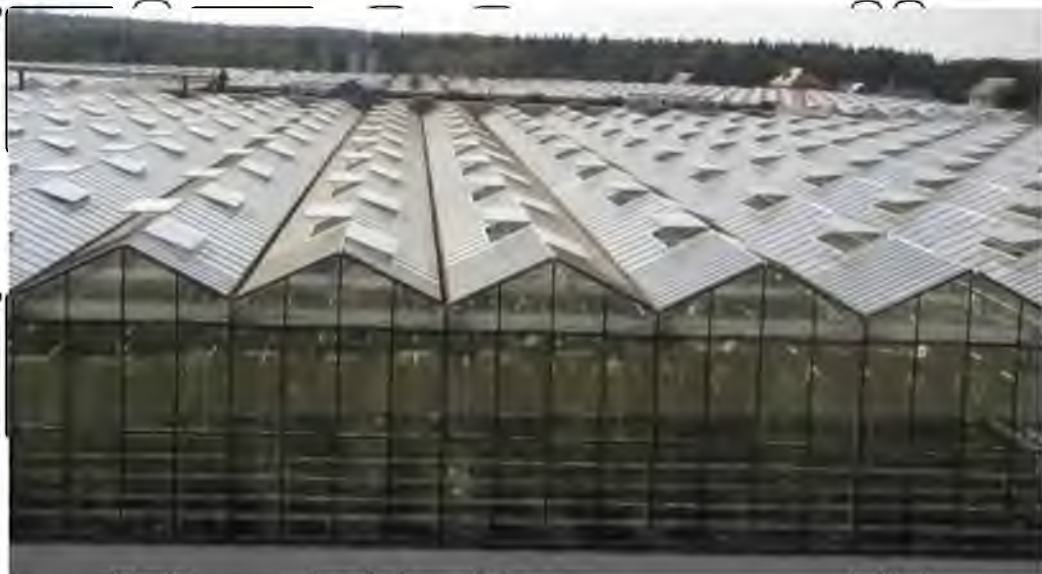
Рис. 1.9. Загальний вид вентиляційних фрамуг
