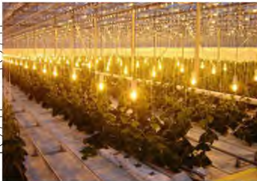
Рис. 1.11. Загальний вид системи електро-досвічування рослин
