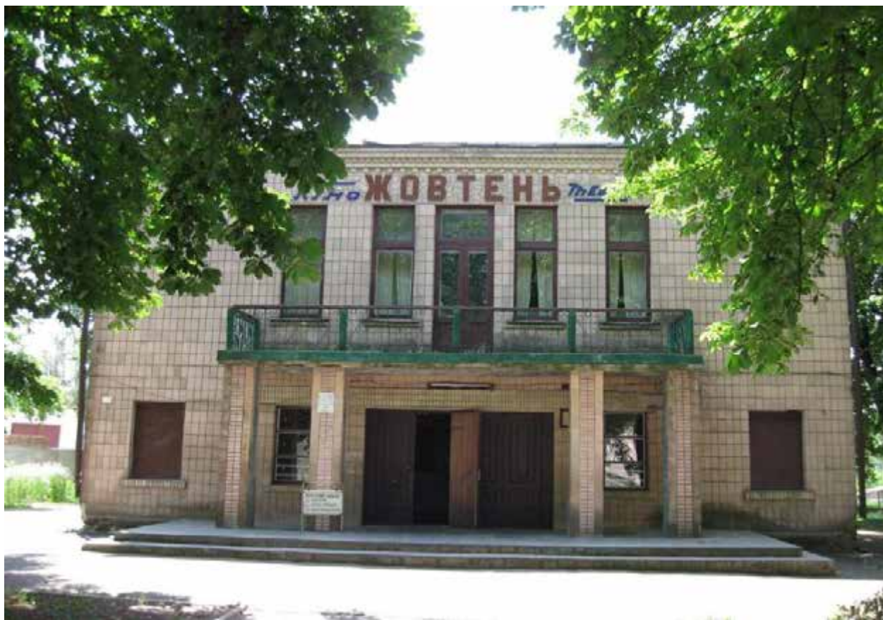
Рис. 2.1. Стан будівлі кінотеатру «Жовтень» (2009) [17]
