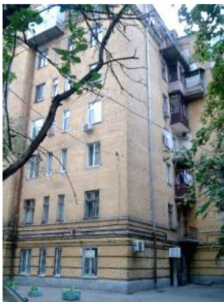
Рис. 1. Загальний вид дворового фасаду житлового будинку (на першому поверсі експлуатується віброактивне обладнання, включаючи кондиціонери)
