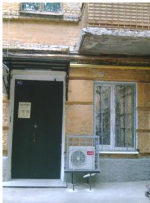
Рис. 3. Загальний вигляд дверного отвору на першому поверсі та встановленого на ґрунті кондиціонера під житловими приміщеннями квартири
