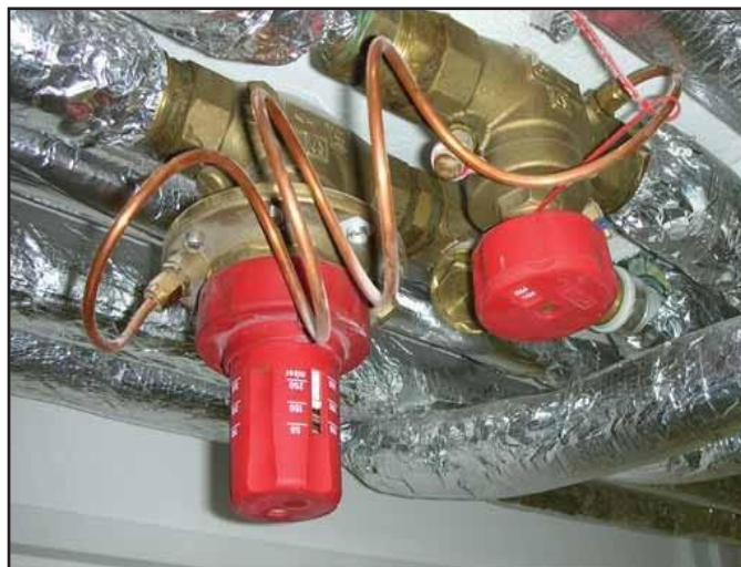
Рисунок 5.24 - Балансувальний вентиль Штрьомакс GR 4217 і автоматичний регулятор перепаду тиску Герц 4007
