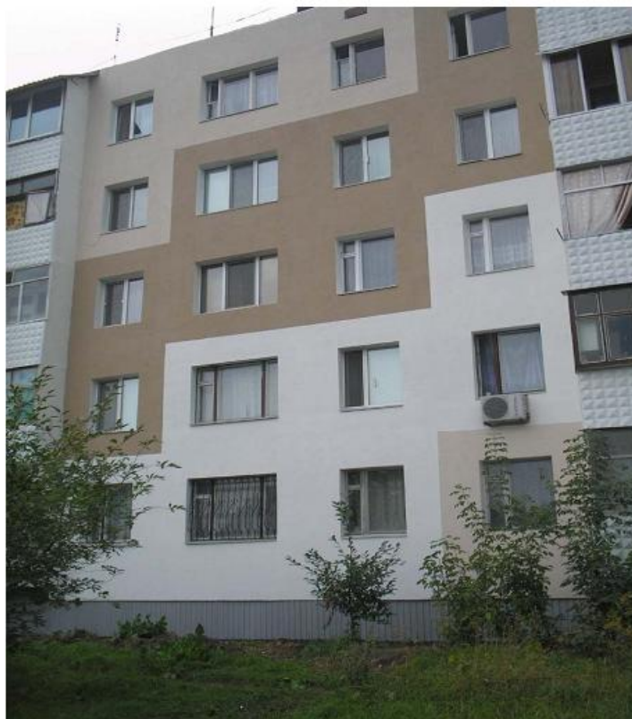
Рисунок 5.5 – Вигляд будинку з утепленими стінами
