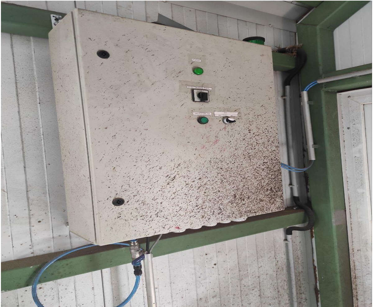
Рис. 4.3. Шафа контролю процесу сканування лісосировини металодетектором
