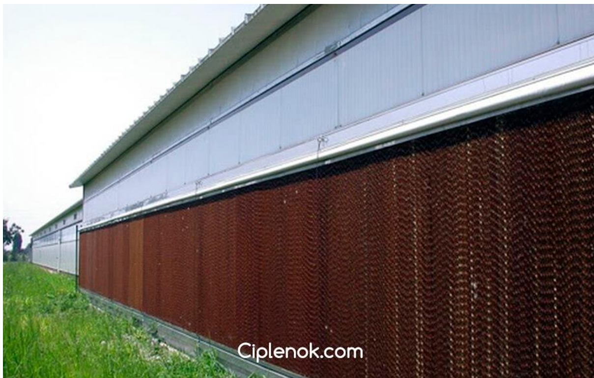
Рис. 2.1. Випарне охолодження повітря в пташнику
