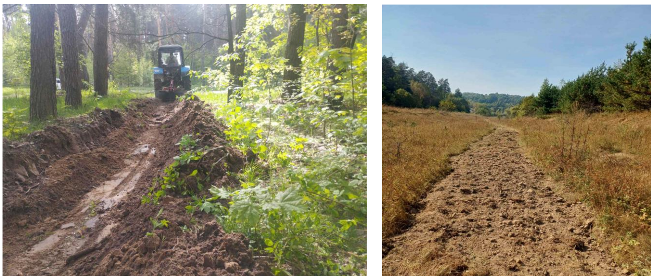
Рис. 4.12 Створення мінералізованих смуг
