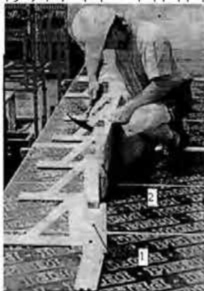
мал.14. Монтаж відсікача
