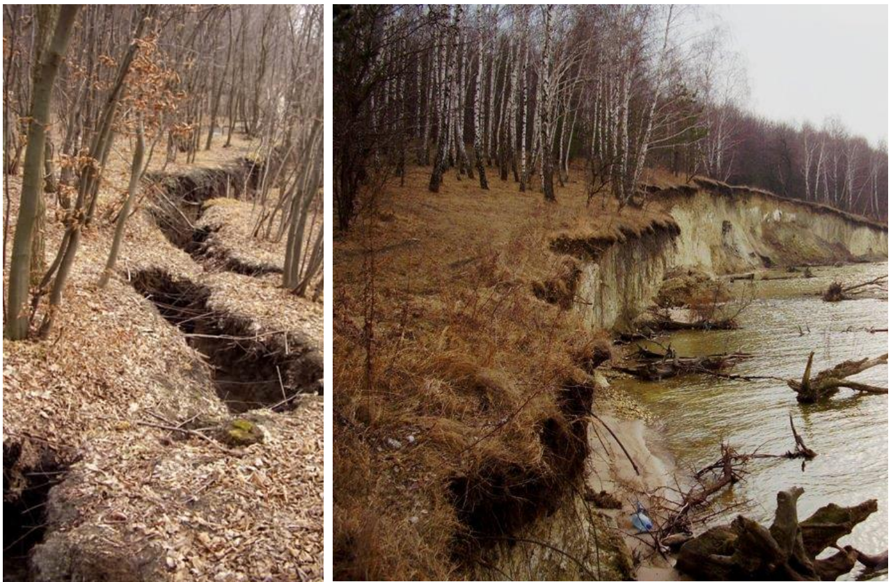
Рис. 2.3. Сліди деформації — тріщини в ґрунті відбуваються в межах РЛП “Трахтемирів” [39]
