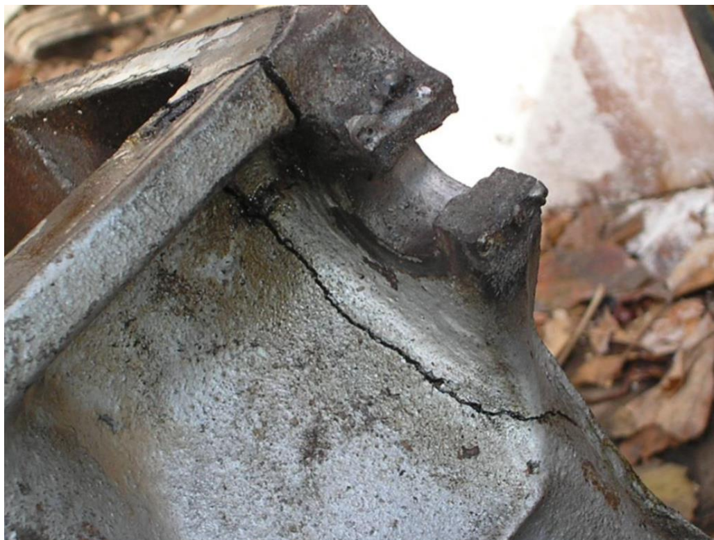
Рис. 4.1. Корпус КЗП з тріщиною, яку відновлювали наплавленням електродом з обмазкою
