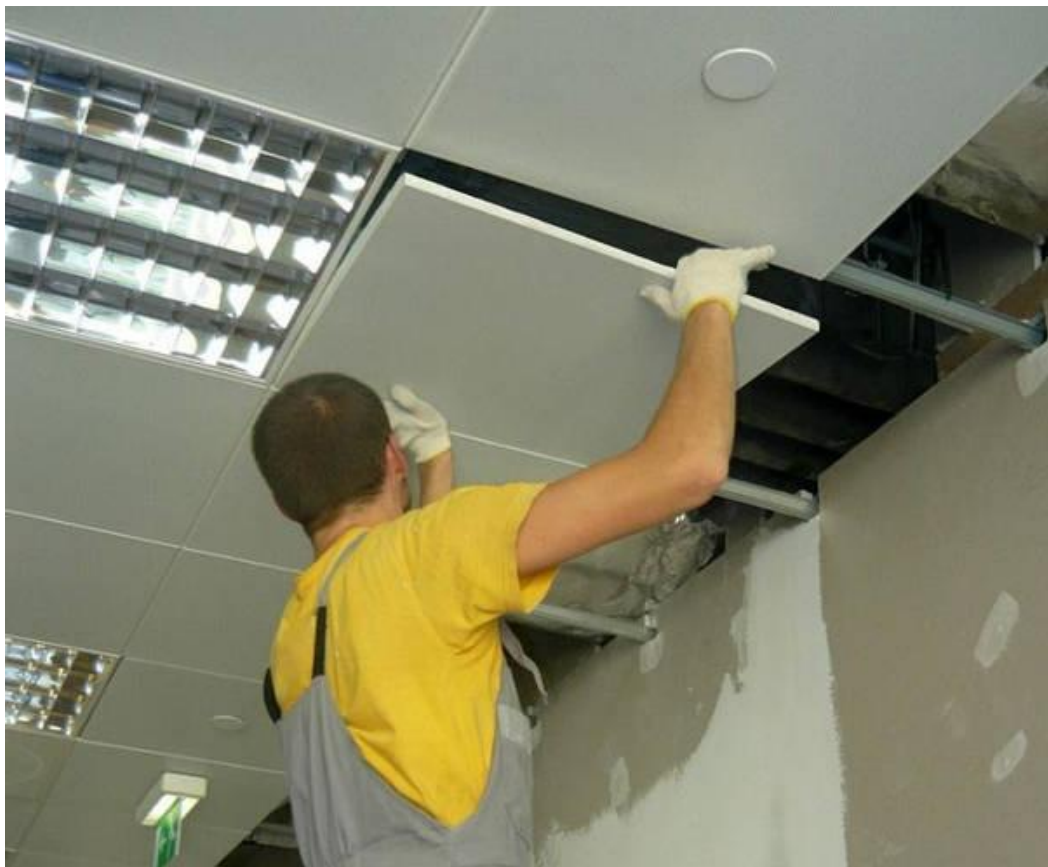
Рис. 3.2 Монтаж стельових плиток.
