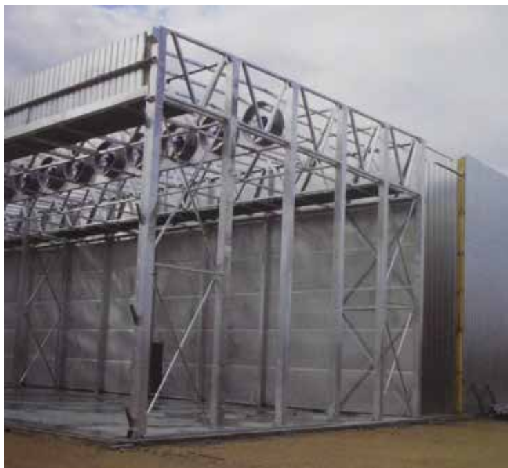
Рисунок 5.11. Несучі конструкції збірних сушарок
