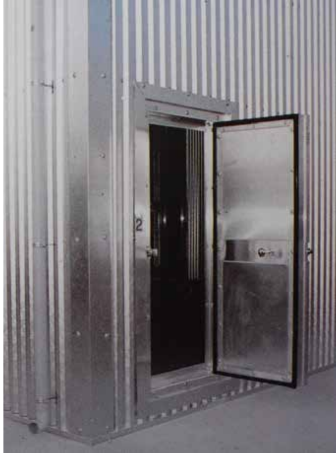
Рисунок 5.15. Конструкція оглядових дверей
