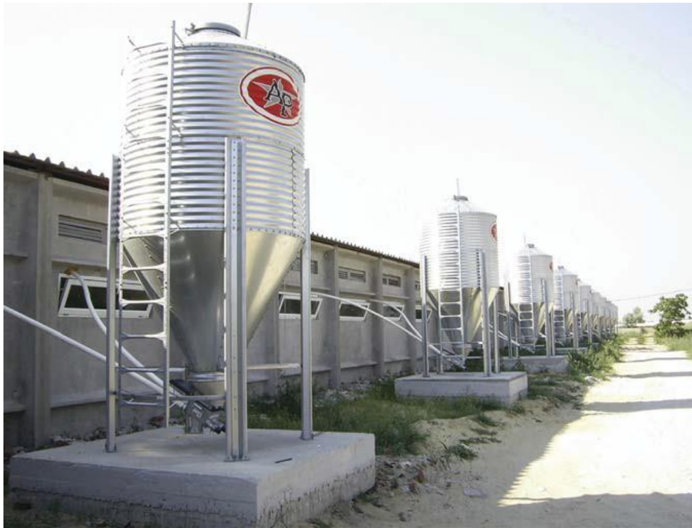
Рис. 2.10. Система бункерів-сховищ кормів для забезпечення роздавання корму свиням GSI- Group 2
