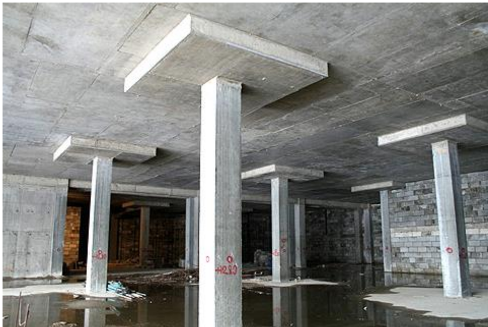
Рисунок 1 – Підсилення колон за допомогою капітелей
