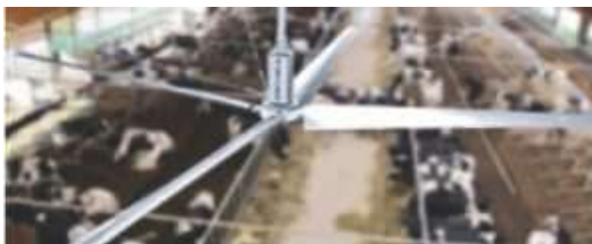
Рис. 1.5. Стельові вентилятори
