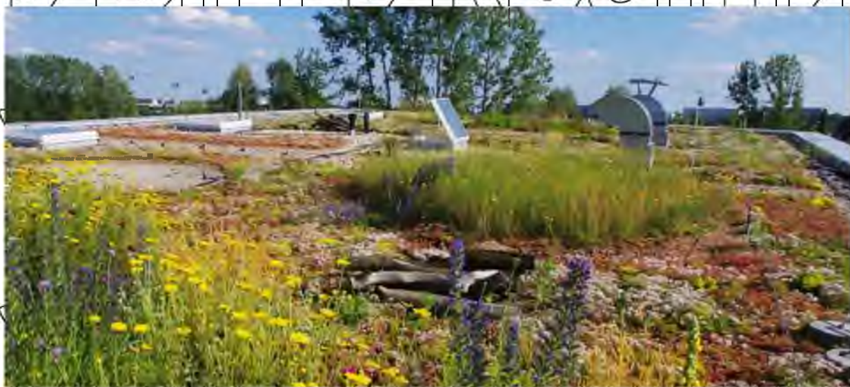
Рис. 1.12. Екстенсивне озеленення даху з седумів та посухостійких багаторічників, ZinCo Україна, [64]
