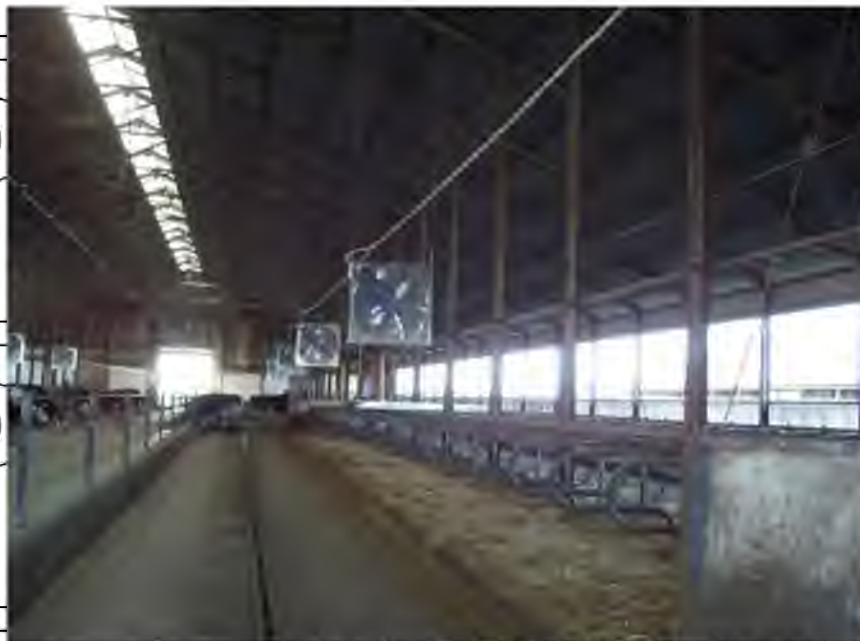
Рис. 1.1. Приміщення нового корівника.
