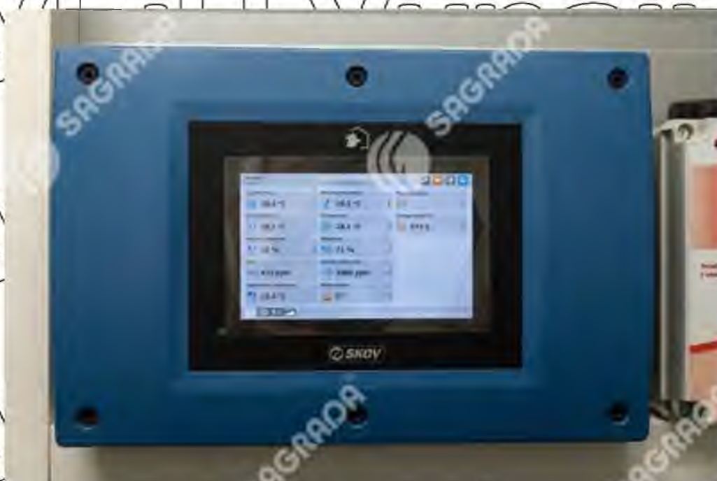
Рис. 3.23 Комп'ютер керування мікрокліматом DoI 530 СТ+Р з екраном 10"
