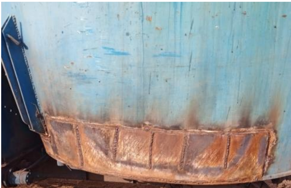
Рис. 2. Відновлена стінка бункера
