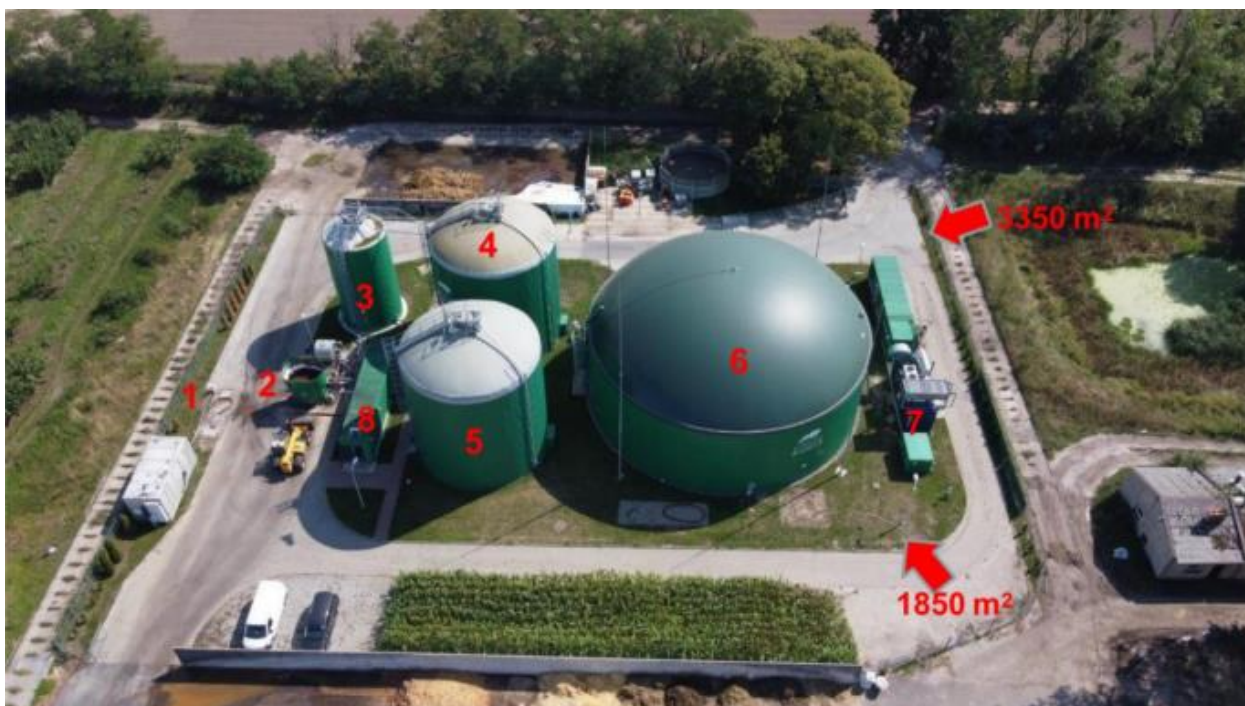
Рис.2.2.1 – Біогазова установка в дослідному господарстві Пшиброда: 1 – резервуар для рідких субстратів; 2 – Завантажувальний бункер для твердих субстратів; 3 – гідролізатор; 4 – перший ферментер; 5 – вторинний ферментер; 6 – резервуар дигестату; 7 – ТЕЦ; 8 – контрольний контейнер.
