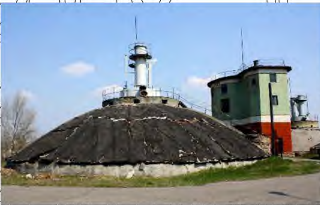
Рисунок 1.5 – Метантенник на Бортницькій станції аерації
