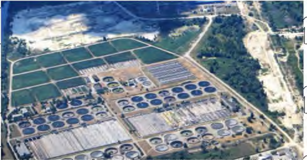
Рисунок 1.3 – Загальний вигляд Борзняцької станції аерації
