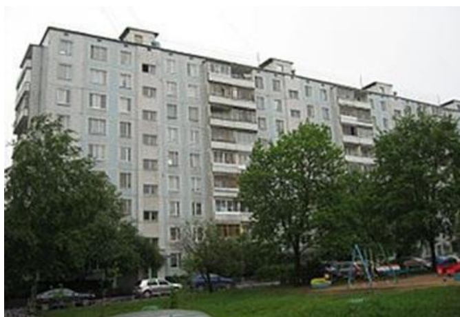
Дев'ятиповерховий багатосекційний панельний будинок серії П-49
