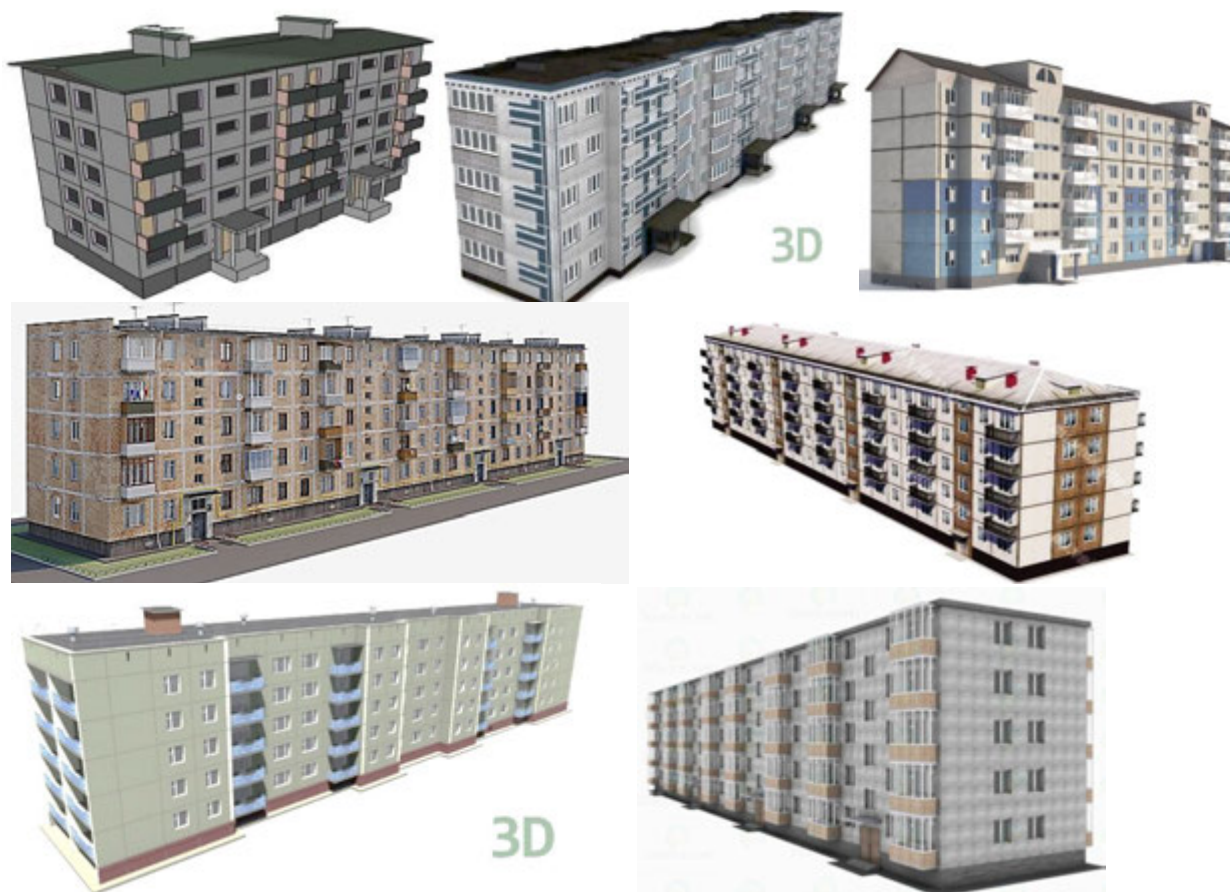
Рис. 1.1. Типові серії панельних житлових будівель які зводили наприкінці 60-х років
