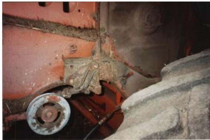
Рисунок 3.2 - Тріщина рами і обрив кронштейнів з лівого боку комбайна
