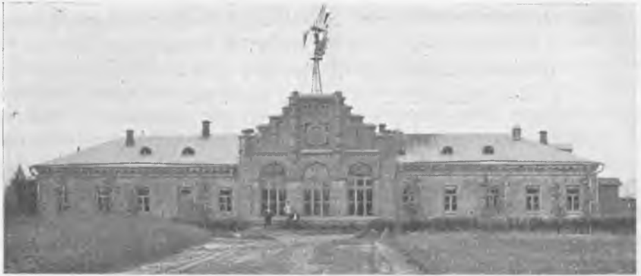
ГЛАВНОЕ ЗДАНИЕ СТАНЦИИ.
