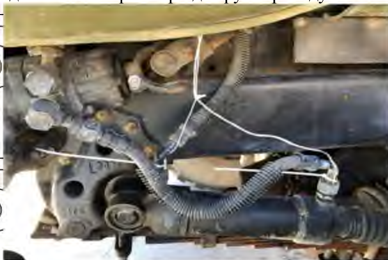
Рис. 3.5 Місця під'єднання термопар №2 та №3 до трубопроводів силового циліндра
