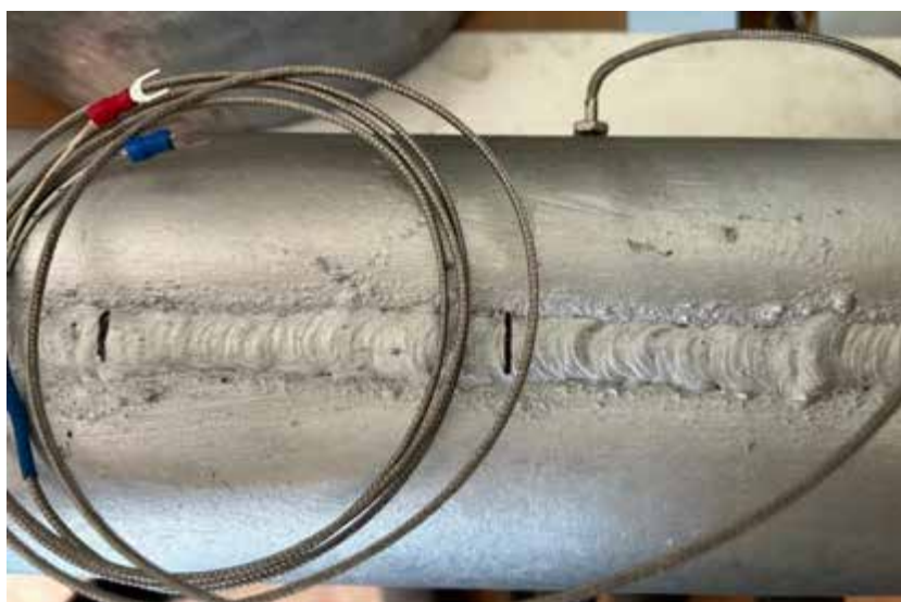
Рис. 4.12 Монтаж термопари в корпусі шнека
