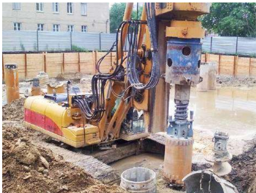
Рис. 6.1. Улаштування фундаментів на бурових палях
