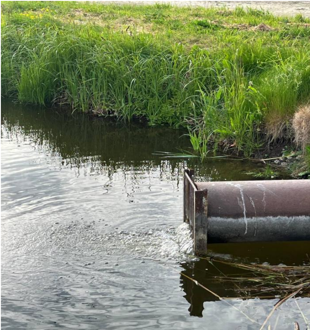
Рис. 2.3. Водонапуск в третьому зимувальному ставі
