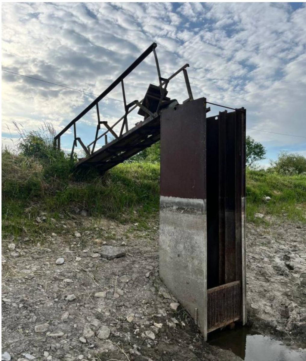
Рис. 2.4. Водоспуск типу «Монах»
