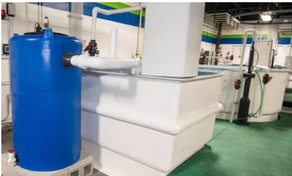
Рис. 3.3.4. Біологічний фільтр
