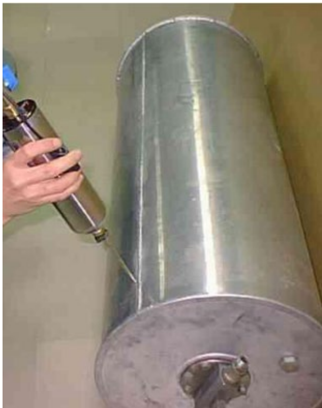
Рис. 4.6. Герметизування протікання кріогенних місткостей
