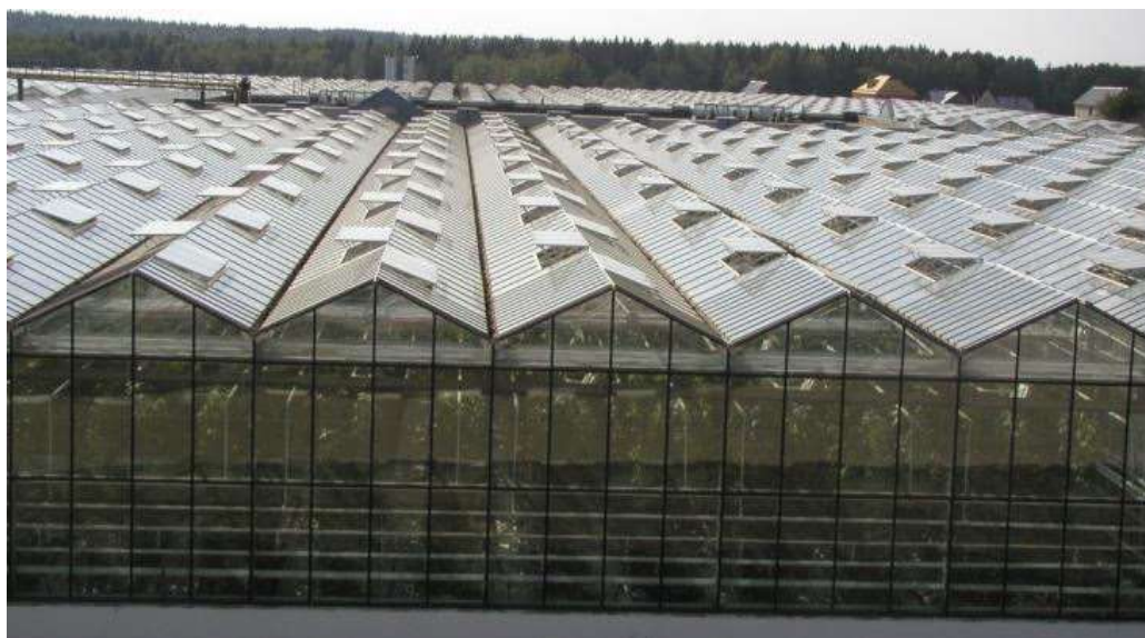
Рис. 1.9. Загальний вид вентиляційних фрамуг
