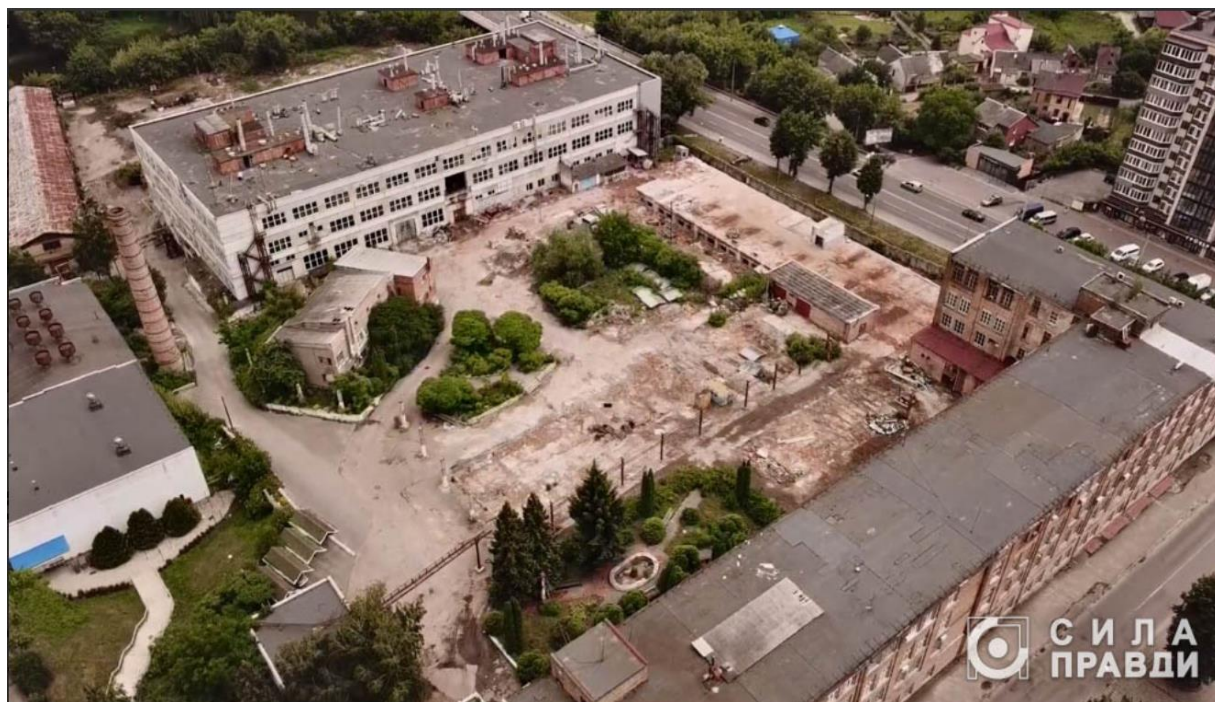
Рис. 2.3. Вид зверху на територію заводу [4]
