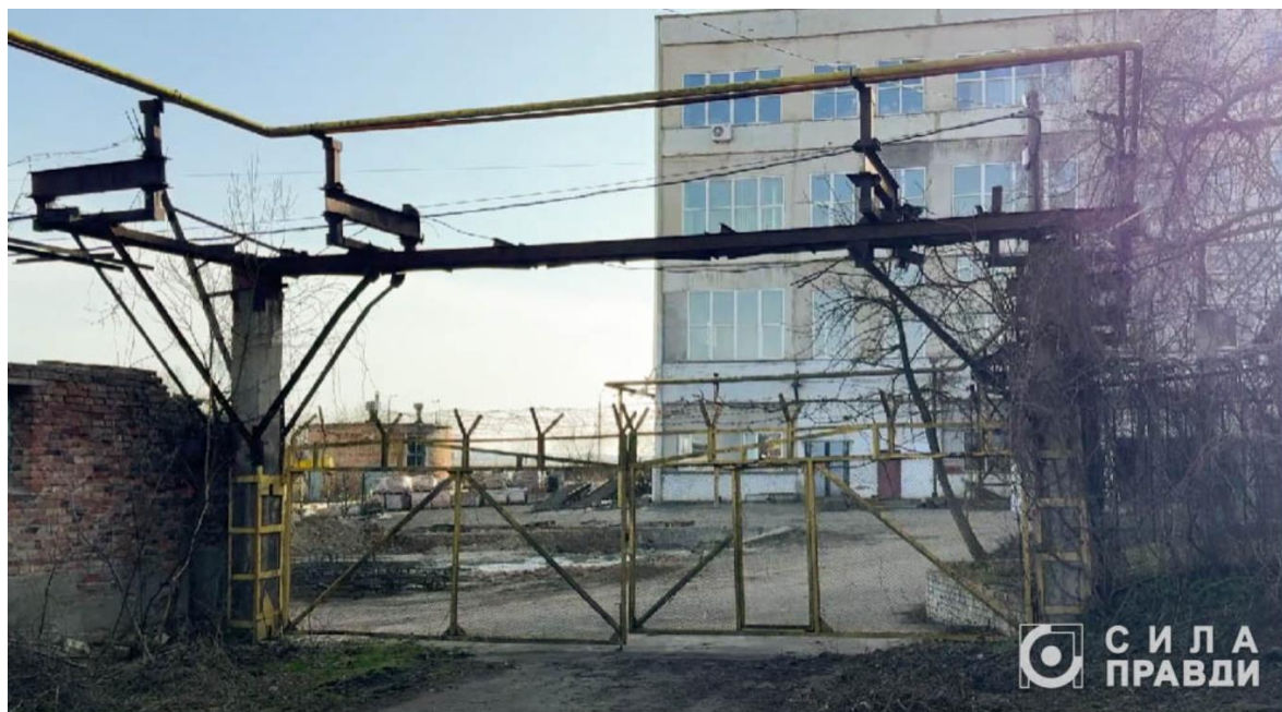
Рис. 2.4. Вхід на територію заводу [4]
