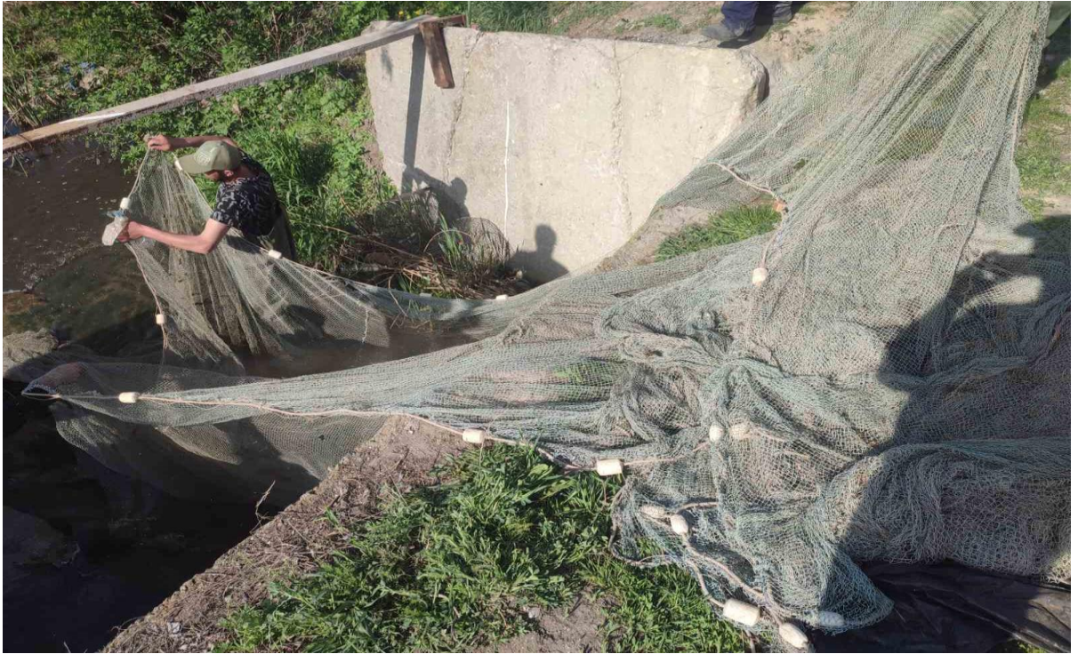
Рис. 3.2. Процес монтування рибовловлювальної конструкції
