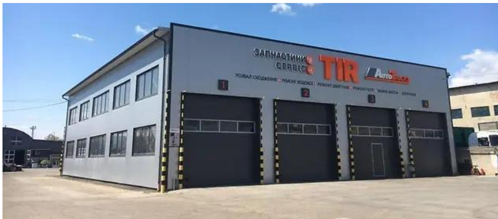
Рис. 2.1. Фото території станції технічного обслуговування ТОВ «TIR AVTO GROUP»
