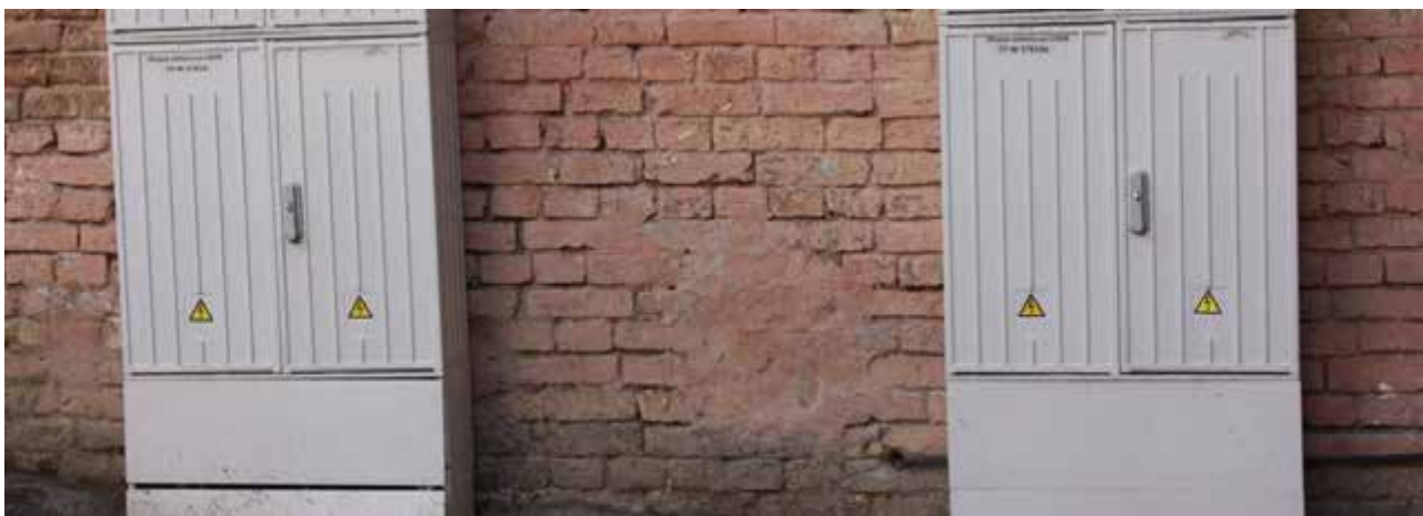
Рис. 1.2. Зовнішній вигляд шафів силових розподільних типу СКУ
